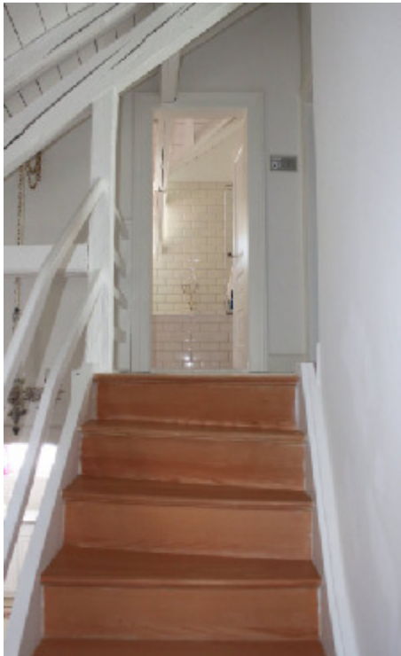
Treppengeländer [+ \delta , + \omega ]. Bionstr. o.N. (Flarzhaus), 8006 Zürich
